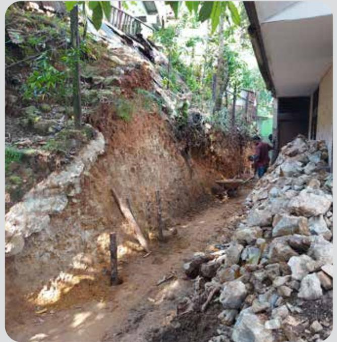
Tampak bagian belakang kantor saat dilakukan pembuatan talud (dinding fondasi belakang agar tidak longsor)
